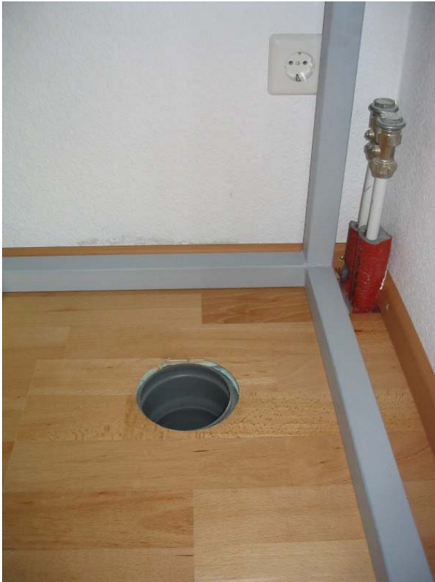
Durchbruch mit HT-Rohr
