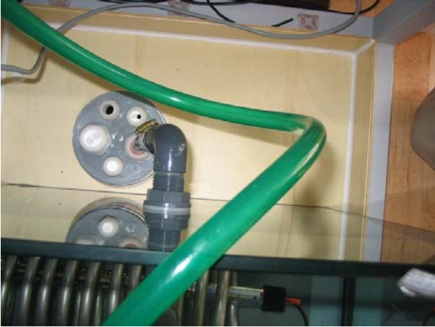
Durchbruch von oben, mit Ablauf Filter
