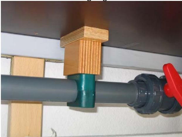
Schellen und Befestigung
