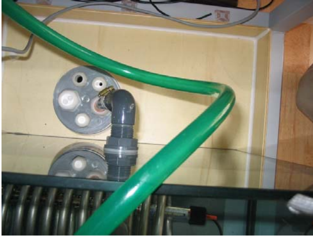
Durchbruch von oben, mit Ablauf Filter
